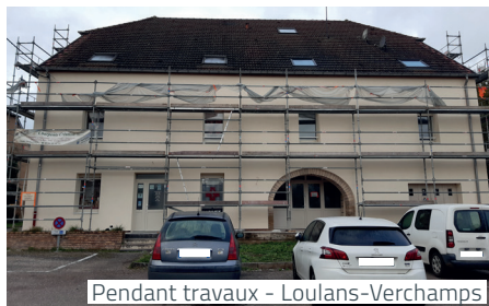
Pendant travaux - Loulans-Verchamps
