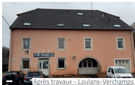
Après travaux - Loulans-Verchamps
